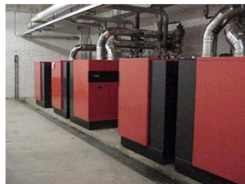
Рис. 4.1 Пример установки конденсационных бойлеров
