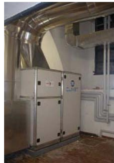
Рис. 3.13 типичная внутренняя установка кондиционера серии СРН-V
