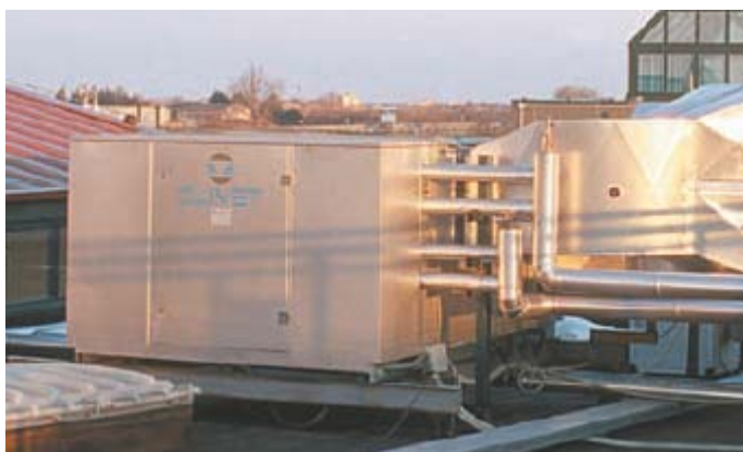
Рис.3.9. Пример установки на крыше блока серии CRH.
