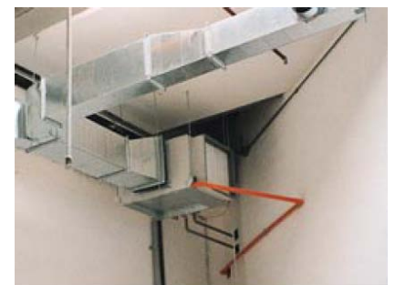
Рис. 3.6. Пример потолочной установки канального кондиционера серии СН.
